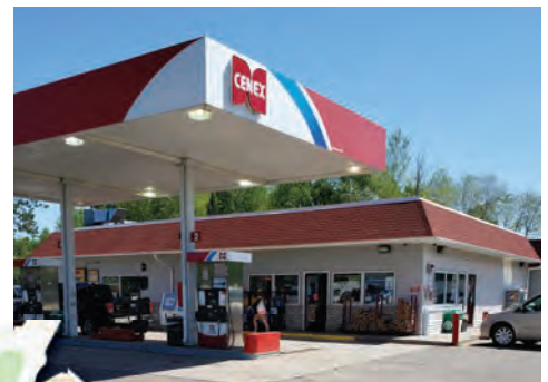
Lake Holcombe C-store
